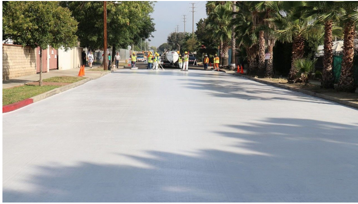
Revêtement clair sur une route à Los Angeles | Bureau of Street Services, Los Angeles
